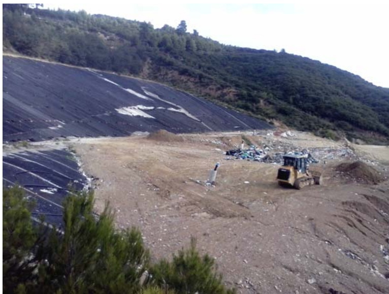
Εικόνα 7. Χώρος υγειονομικής ταφής απορριμμάτων που λειτουργεί σύμφωνα με τους κανονισμούς.
