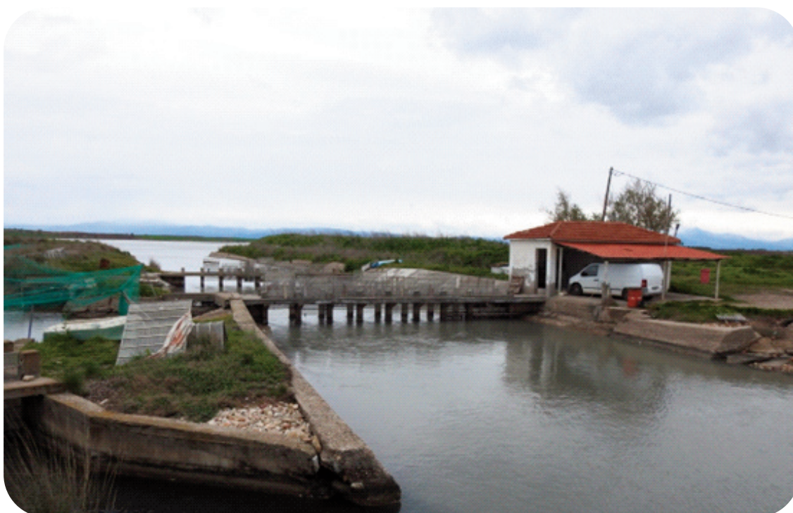
Εγκαταστάσεις για τη σύλληψη ψαριών στη Λιμνοθάλασσα Αρωγής στη Ροδόπη. Οι πόρτες που επιτρέπουν την είσοδο των ψαριών στο ιχθυοτροφείο ανοίγουν την Άνοιξη και κλείνουν το Φθινόπωρο.
