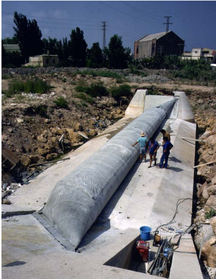
Φωτογραφία 3 Στάδιο κατασκευής του φουσκωτού φράγματος
